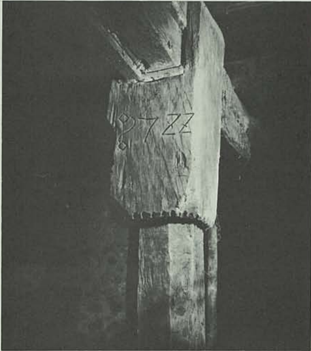
Tragfeiler aus Eichenholz mit der Jahrzahl 1722 (Aufnahme E. Spühler)
