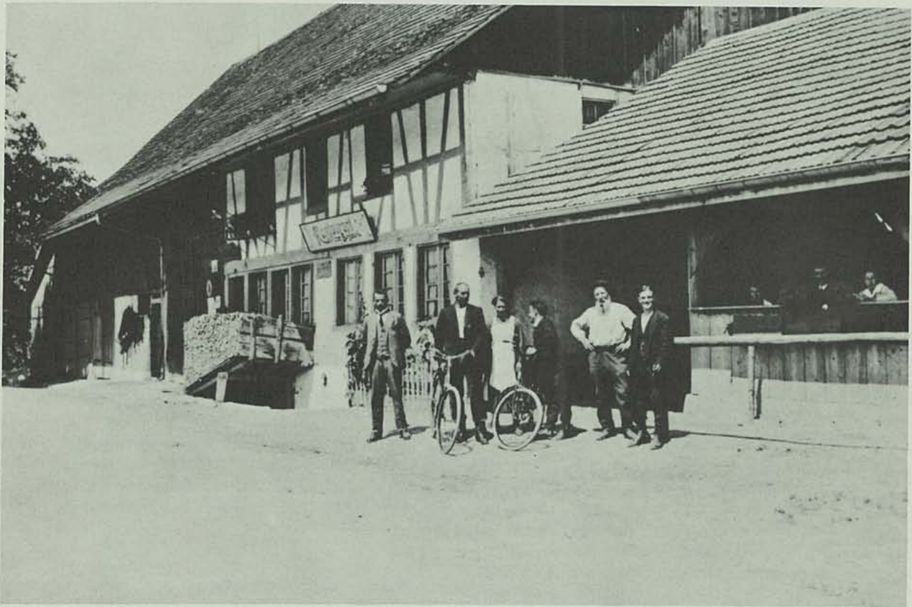
Das alte im Jahre 1923 niedergebrannte Restaurant Bergwerk Buchs.
